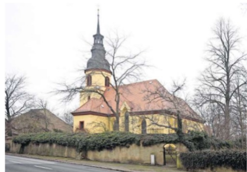
Auch wenn es von Außen nicht sichtbar ist: Das Innere der Pastor-Roller-Kirche muss dringend saniert werden.
